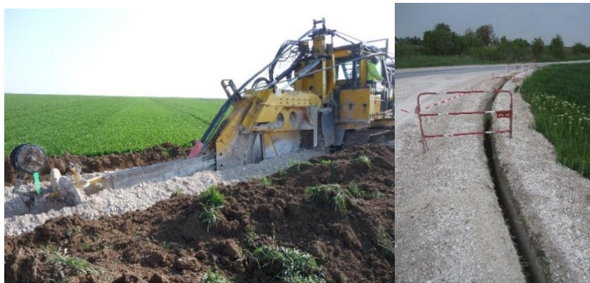
Photo 20 : Exemple de tranchée réalisée (Source : TotalEnergies)
