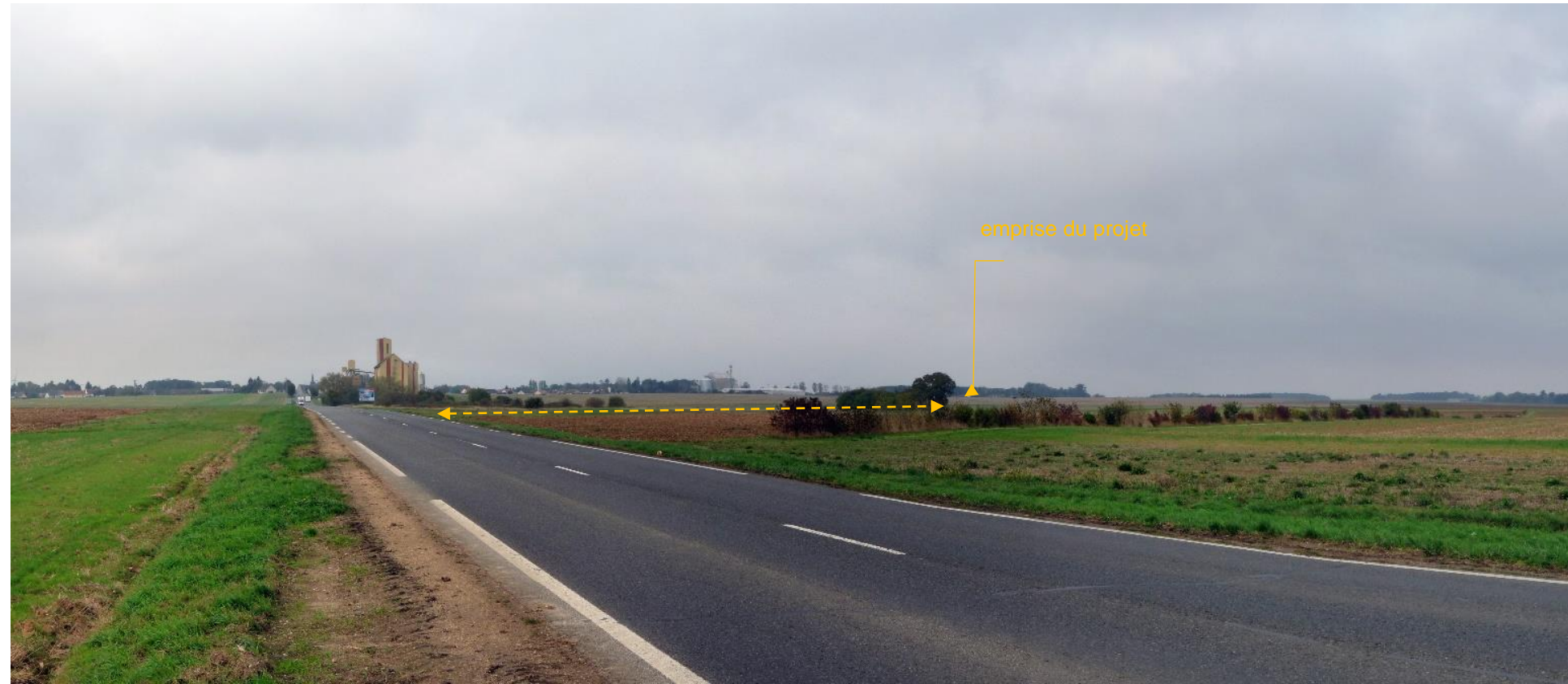
Photo 37 : Vue 2, depuis l'aire stationnement le long de la RD 357. L'emprise du projet apparaît nettement. (Source : IEA, 2020)
