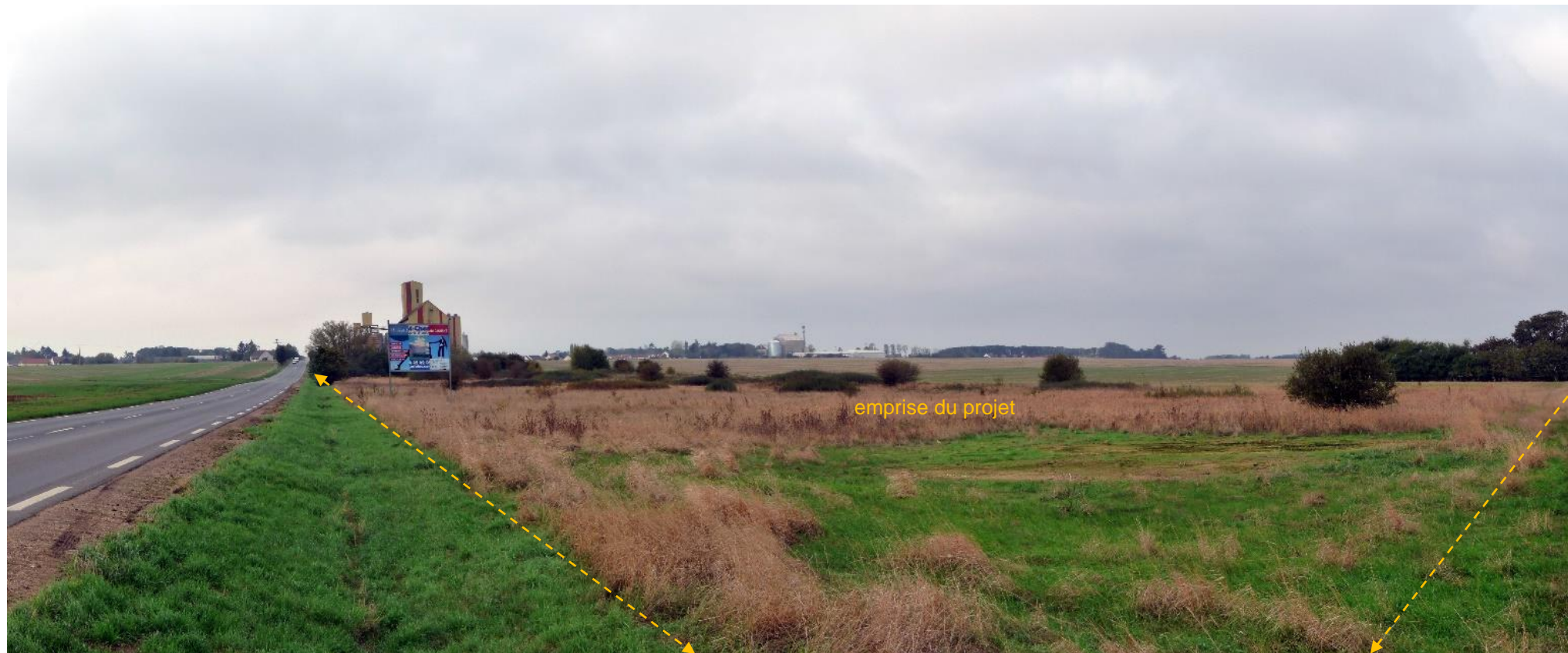
Photo 38 : Vue 3, depuis la RD 357 et le chemin agricole longeant l'extrémité est de l'emprise du projet (Source : IEA, 2020)
