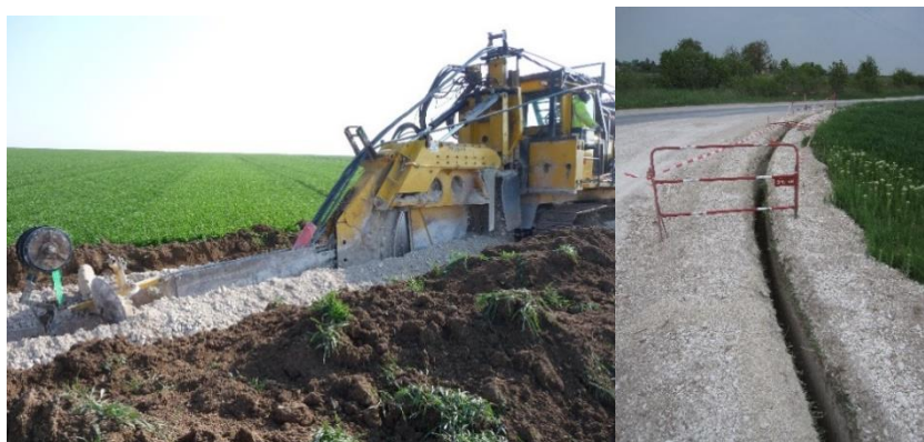
Photo 54 : Exemple de tranchée réalisée (Source : TotalEnergies)
